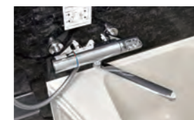
サーモスタット付シャワー水栓 あらかじめ設定した一定温度で利用できる、自動制御による温度調節機能付です。
