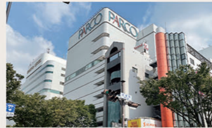
■名古屋PARCO (「矢場町」駅/直結) 東館・西館・南館・midiの全館においてファッション関連を中心にさまざまなアイテムが揃えられ、さらに映画館、ホテル、eスポーツスタジアムなどが併設されています。
